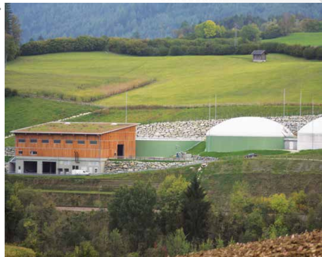
Intégration paysagère d'une unité de méthanisation.
